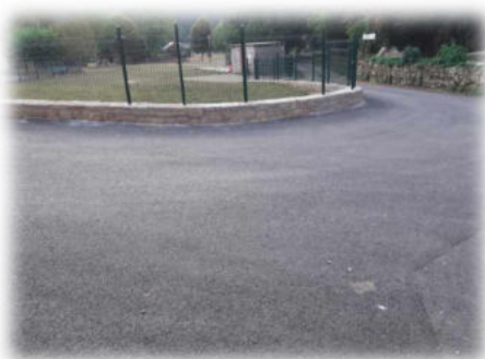
Rue du pont de la Chapelle
